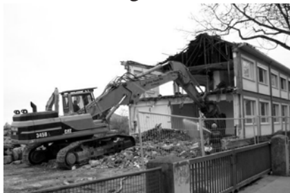
Abriss eines zuvor kurz besetzten Hauses in der Elsässerstraße
