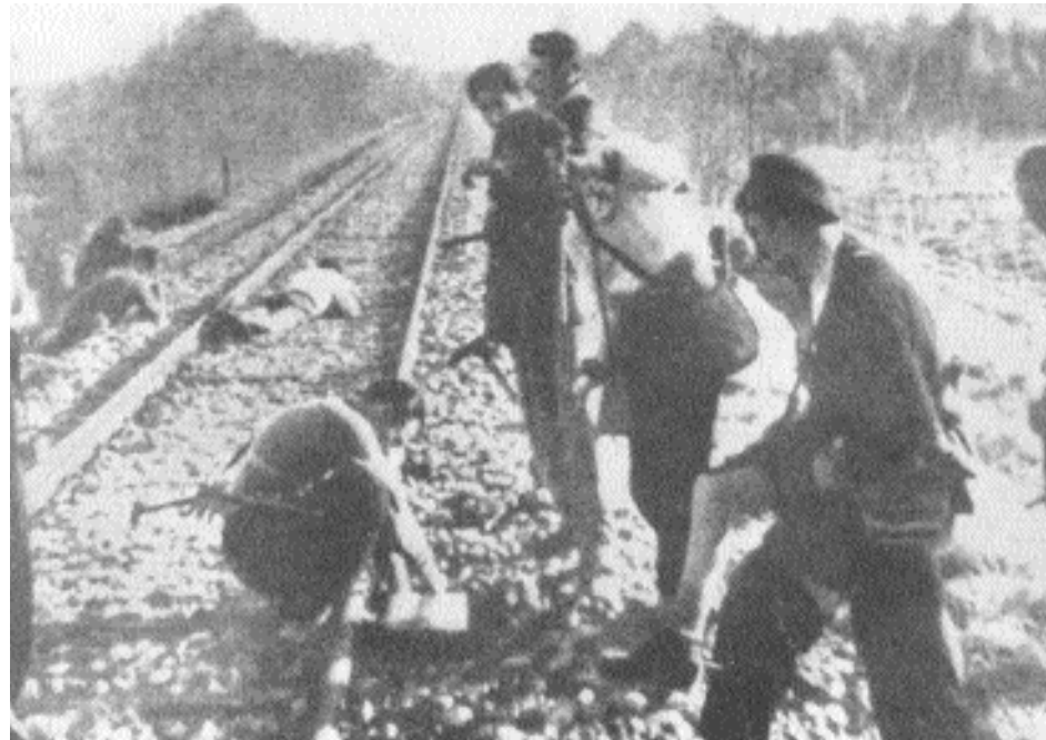
GAP-Gruppe will Eisenbahngleise sprengen
