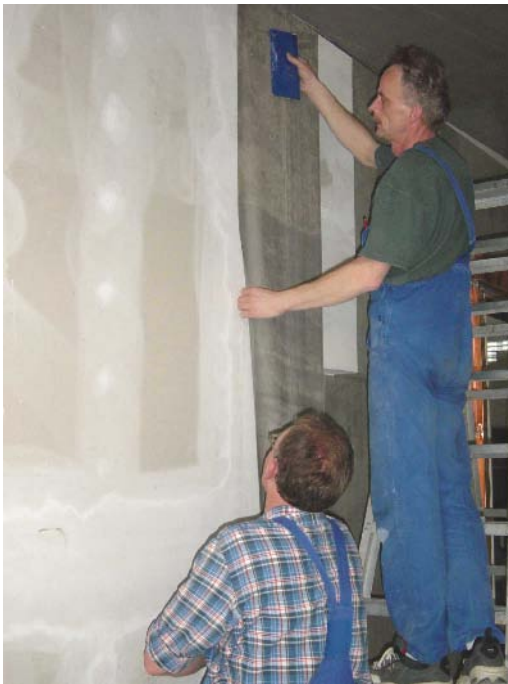
Bild 4.47 Überlappende Verarbeitung von Schirmungsmaterial auf Nylonbasis.
