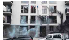
Farbattacke. Das Haus in der Johannerstraße in Kreuzberg wurde großflächig besprüht. Foto: Jörn Hasselmann
