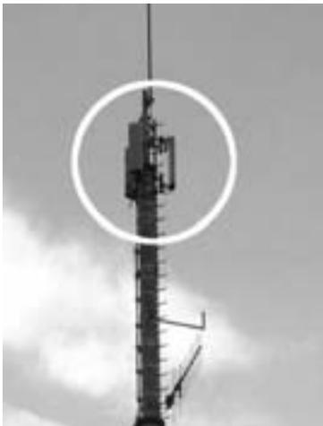
TETRA-Antenne (ähnelt stark Mobiltelefon-Antennen; charakteristisch sind drei Strahler)
