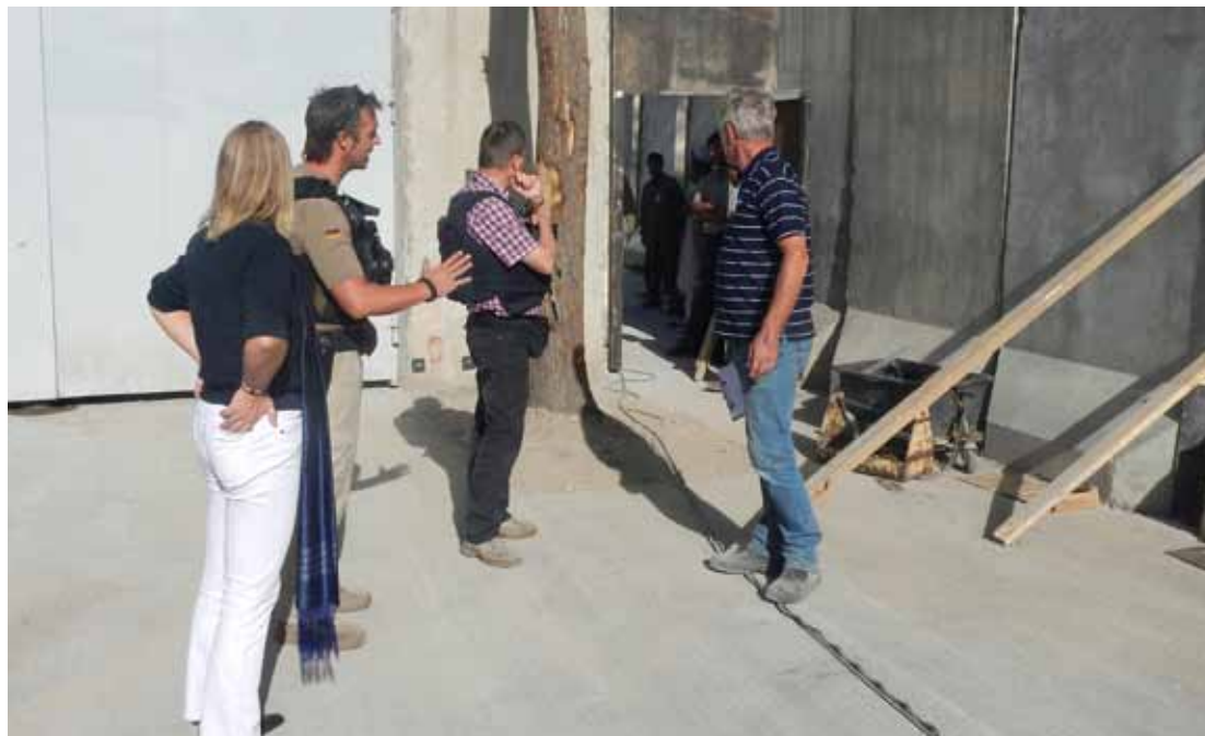
Als Vertreter des Sicherheitsbeamten der Botschaft in Kabul berät Tom Becker auch bei materiellen Sicherheitsfragen, wie etwa bei der Außenumfriedung durch Betonwände (sog. T-Walls).
